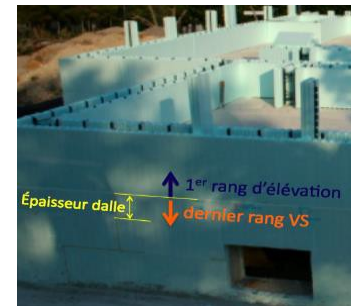
Figure 13 : Continuité de l'isolation au droit des planchers
