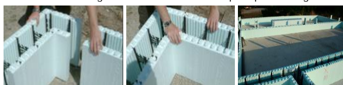
Figure 3 : Démarrage des murs au droit des angles
