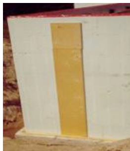
Figure 10 : Réalisation d'un joint « hors lignes de coupe ».
