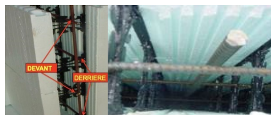
Figure 6 : Mise en place des armatures
