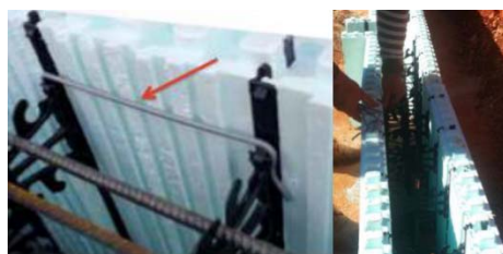
Figure 5 : Liaison horizontale entre les blocs par clips
