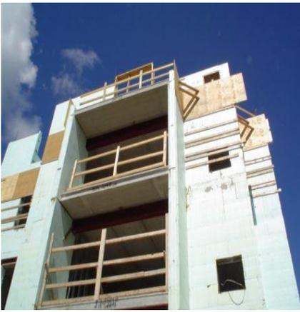
Les ouvertures des fenêtres et des portes sont également préparées pendant la construction à l'aide de matériaux de coffrage permanents ou temporaires qui soutiendront le béton pendant la mise en place. Une fois que le mur a atteint la hauteur prévue, de l'acier d'armature vertical est inséré dans la cavité du mur comme spécifié. Il est recommandé d'utiliser une pompe à flèche et une vibration interne pour assurer une mise en place uniforme et une coulée monolithique.
